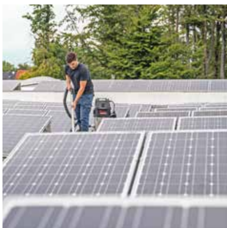
R18 D Nettoyage entre les installations photovoltaïques
