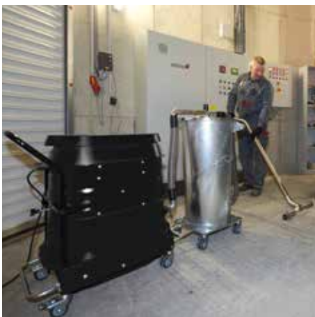
R01 A020 mit Vorabscheider im Heizkraftwerk
