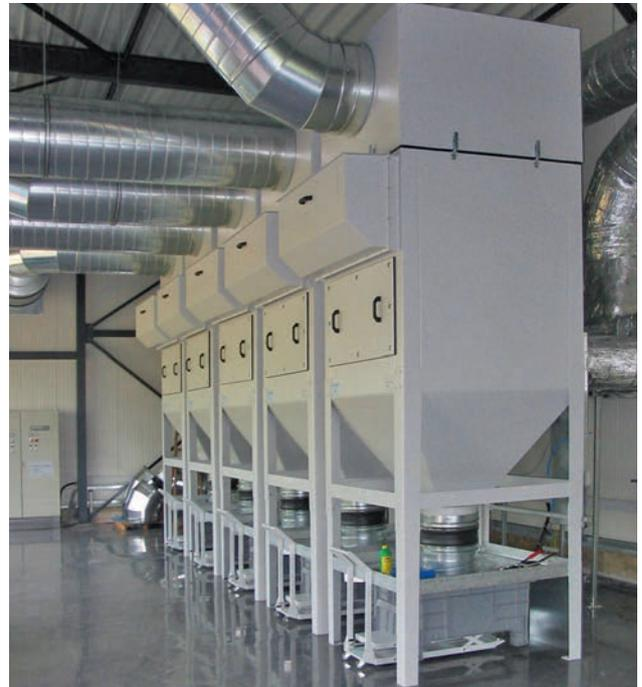
*La technologie d'aspiration et de filtrage de type ASD peut également être la solution centrale pour des ateliers de fabrication complets.*
